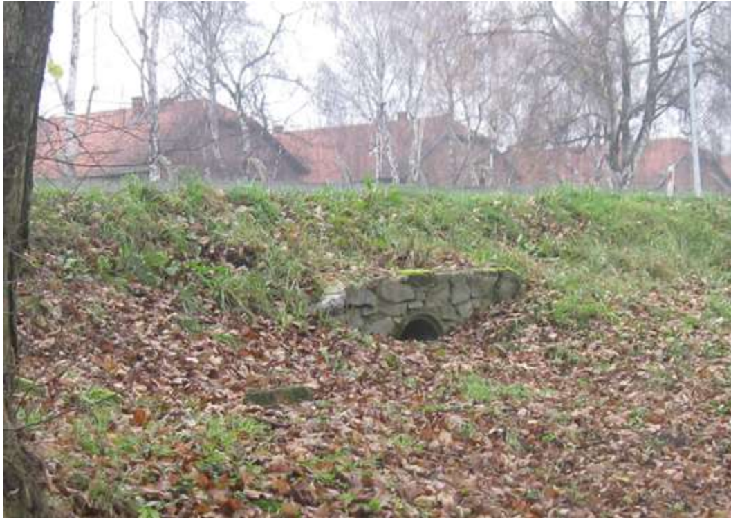
Zdjęcie 2 Istniejący kolektor burzowy w wale przeciwpowodziowym (źródło: dokumentacja własna)
